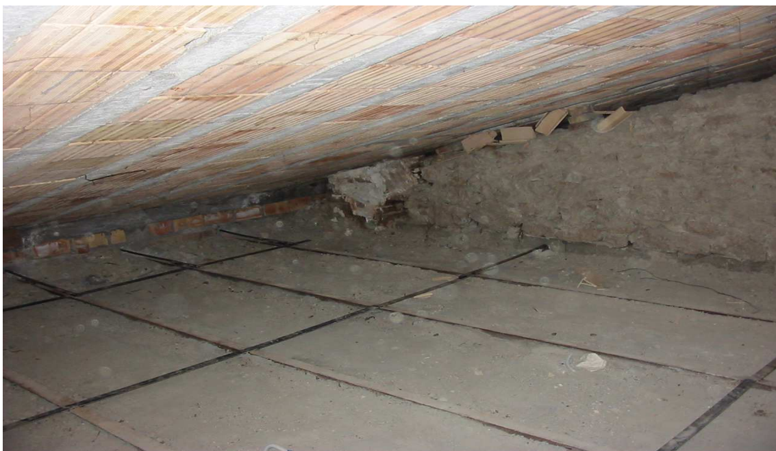
Foto 5 – Particolare solaio di sottotetto con struttura in ferro e tavelloni. Particolare solaio di copertura con struttura in latero-cemento. Particolare quinta muraria di copertura. Particolare cordolatura perimetrale in c.a.
