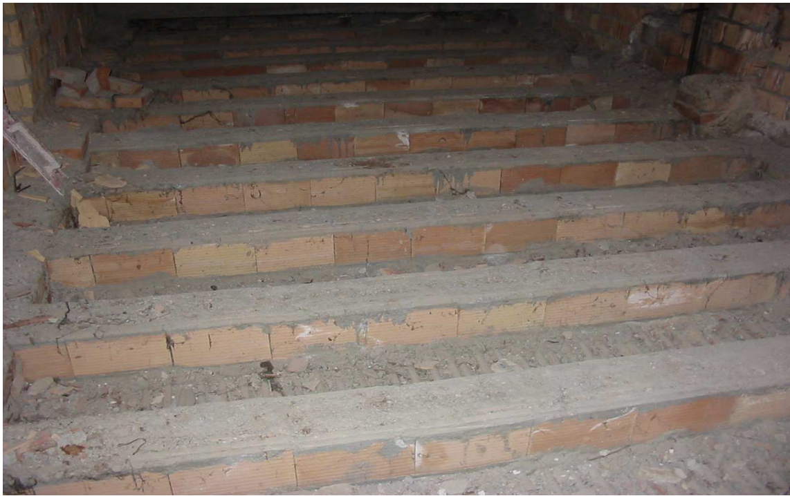
Foto 3 – Particolare solaio di sottotetto con struttura tipo SAP e tabelle di gesso
