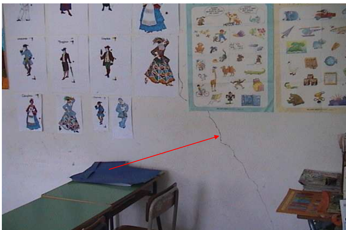
Foto 10 – Particolare lesioni sulle murature interne al 1° Piano.
