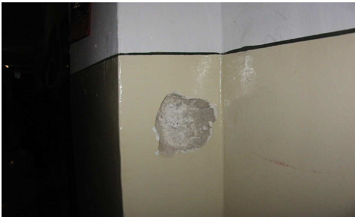
Foto 2 – Particolare muratura d'angolo in pietrame
