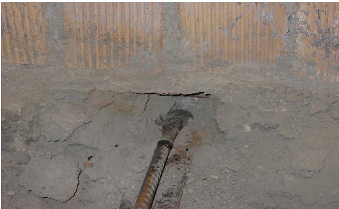
Foto 4 – Particolare solaio di sottotetto con struttura in ferro e tavelloni.
