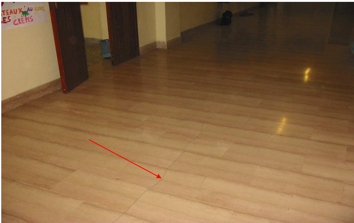
Foto 8 – Particolare lesione sul pavimento a piano terra.
