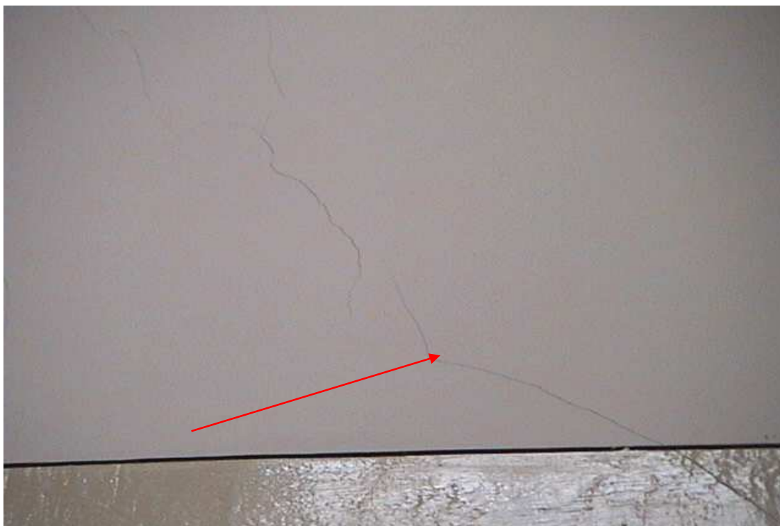
Foto 9 – Particolare lesioni sulle murature interne al Piano terra.
